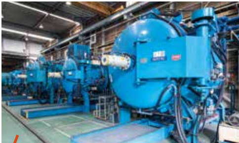
热处理 真空淬火炉
