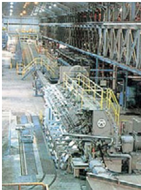
3ロール式線材仕上圧延機 Rolled wire finishing block mill
