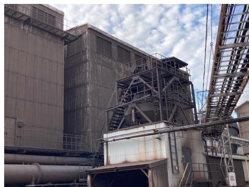
● 製鋼電気炉用集じん機
