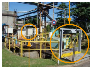
③流出防止(昇降式遮断板)
