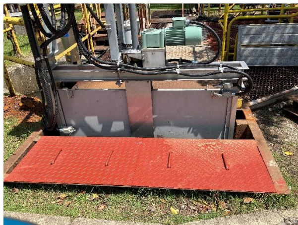
● 排水口 自動遮蔽水門(2024年度設置)
