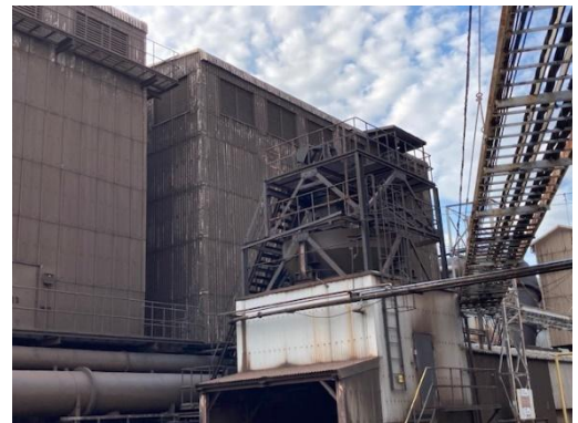
● 製鋼電気炉用集じん機
