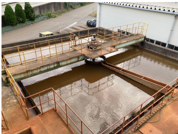
● 酸洗設備用 排水処理施設
